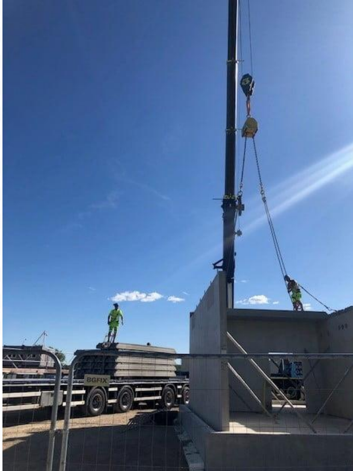
Bild: Montage av väggelement i Kv Almen , Tollarp.
